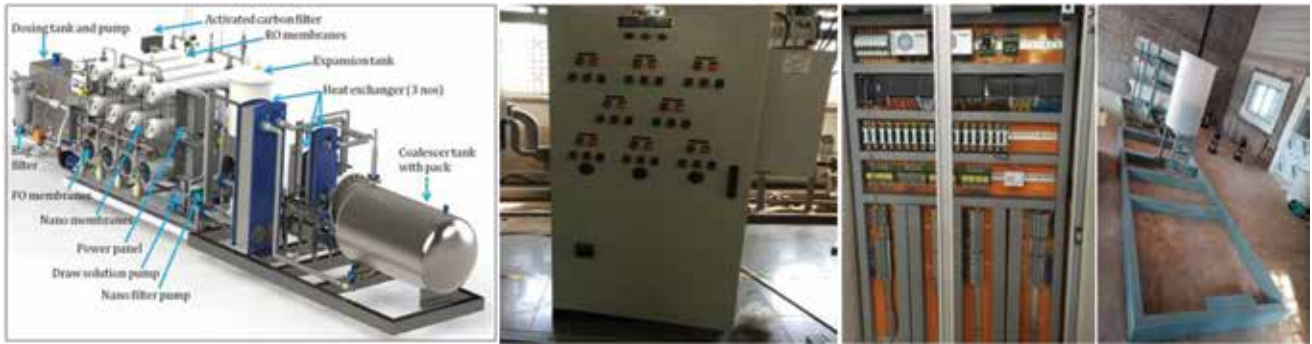
चित्र. 4: नारिपैयूर परीक्षण सुविधा में पीने योग्य पानी उपलब्ध कराने के लिए फॉरवर्ड ऑसमोसिस (एफओ) अलवणीकरण प्रणाली
