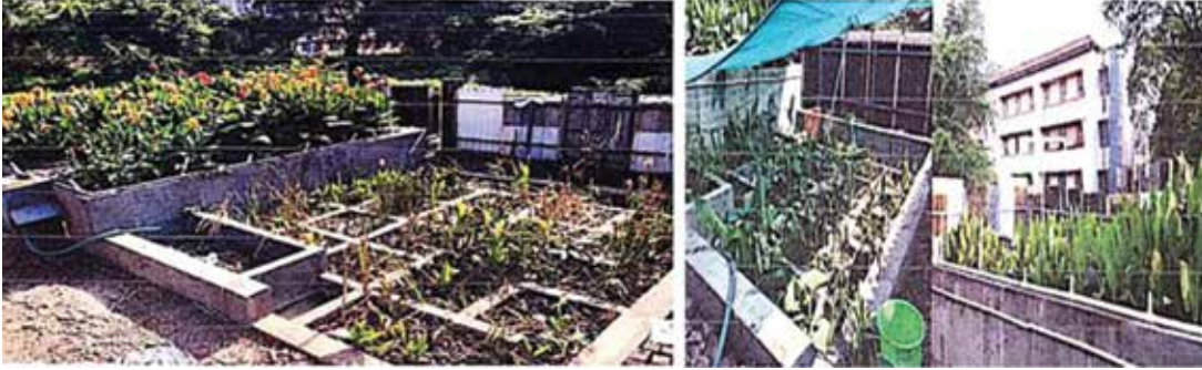
चित्र 10: बहु-प्रजातियों और दोहरे माध्यम से निर्मित वेटलैंड के साथ एकीकृत घरेलू अपशिष्ट जल उपचार प्रणाली
