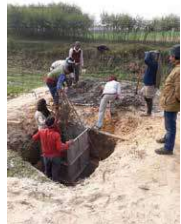
भारत - नेपाल आई.बी. में पिलर निर्माण
