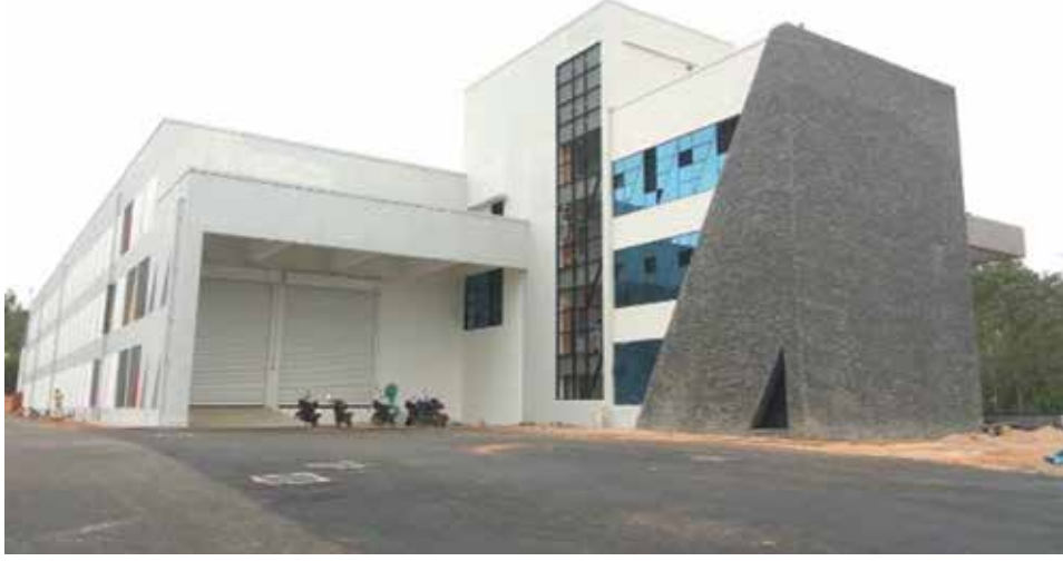
आकृति 3: आईआईए, बंगलुरु के सीआरईएसटी परिसर में अप्टिक्स निर्माण हुआ
